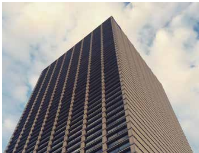
17—Torre do Burgo
